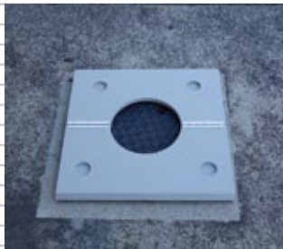
1. マンホールの上に調整プレートを広げて設置します
